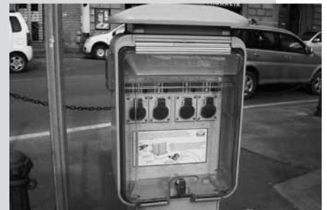
di mezzi elettrici che provvederanno all'adeguamento. I mezzi che possono essere ricaricati sono: biciclette a pedalata assistita; scooter elettrici; veicoli a tre e quattro ruote (fino ad un massimo di 3 kw). Per usare le colonnine di ricarica occorre recarsi in Comune, comunicare i propri dati e ritirare le chiavi per l'apertura/chiusura delle colonnine.
