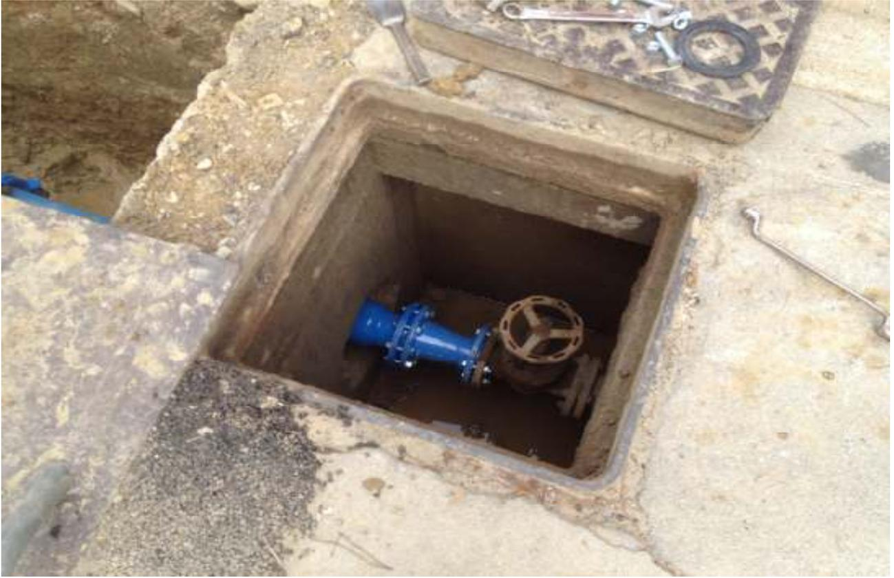
Allacciamento della nuova rete idrica su Via Repubblica di Val d'Ossola all'interno della cameretta
