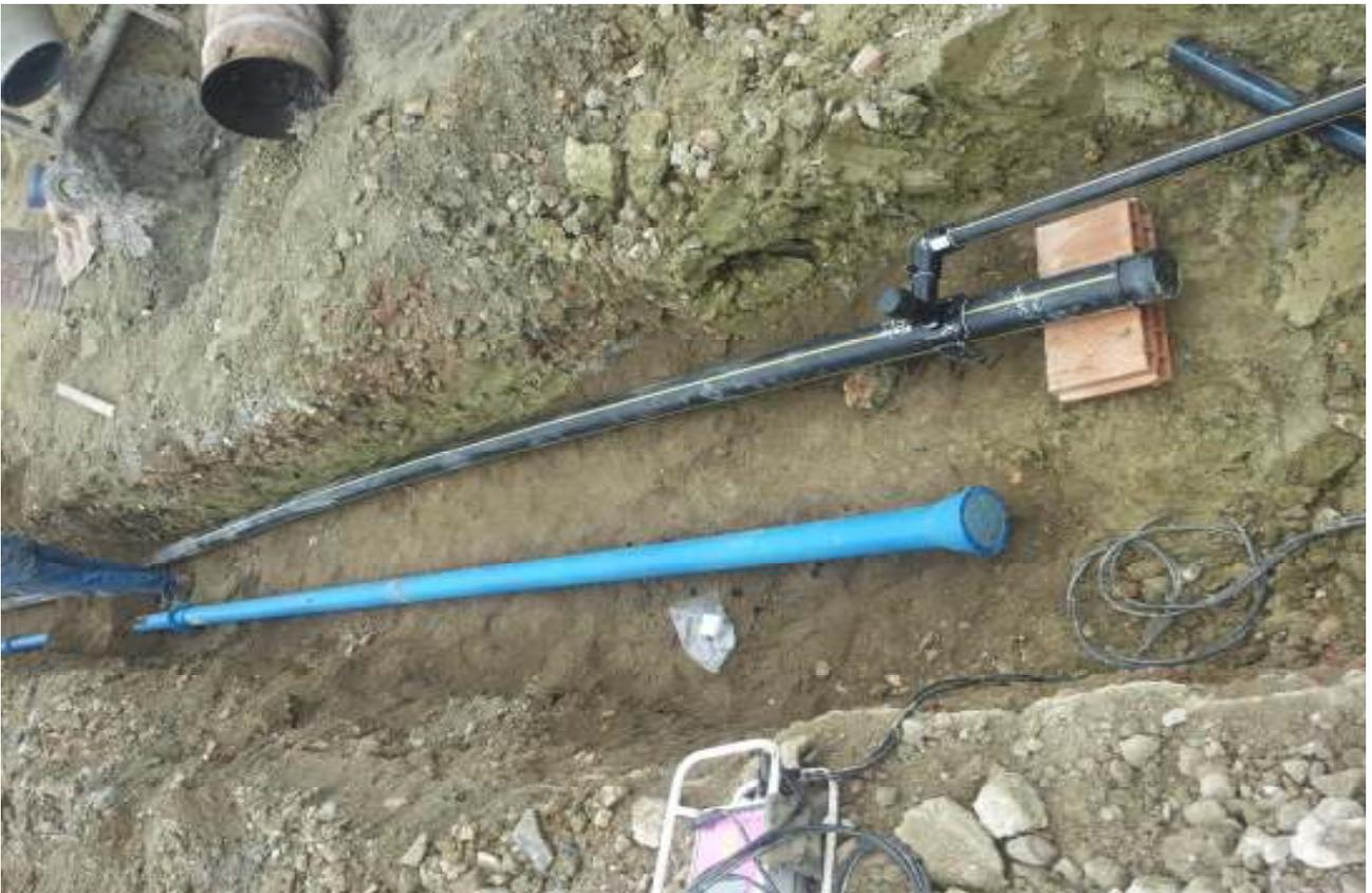
Posa della nuova rete idrica e del gas sul prolungamento di Via Repubblica di Val d'Ossola
