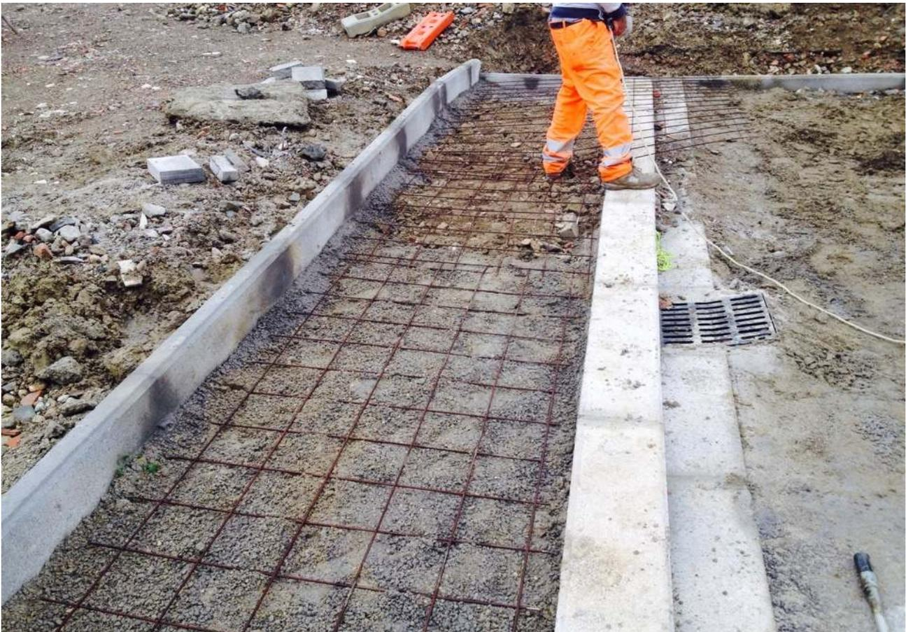
Posa delle rete elettrosaldata per la realizzazione della soletta armata sul marciapiede
