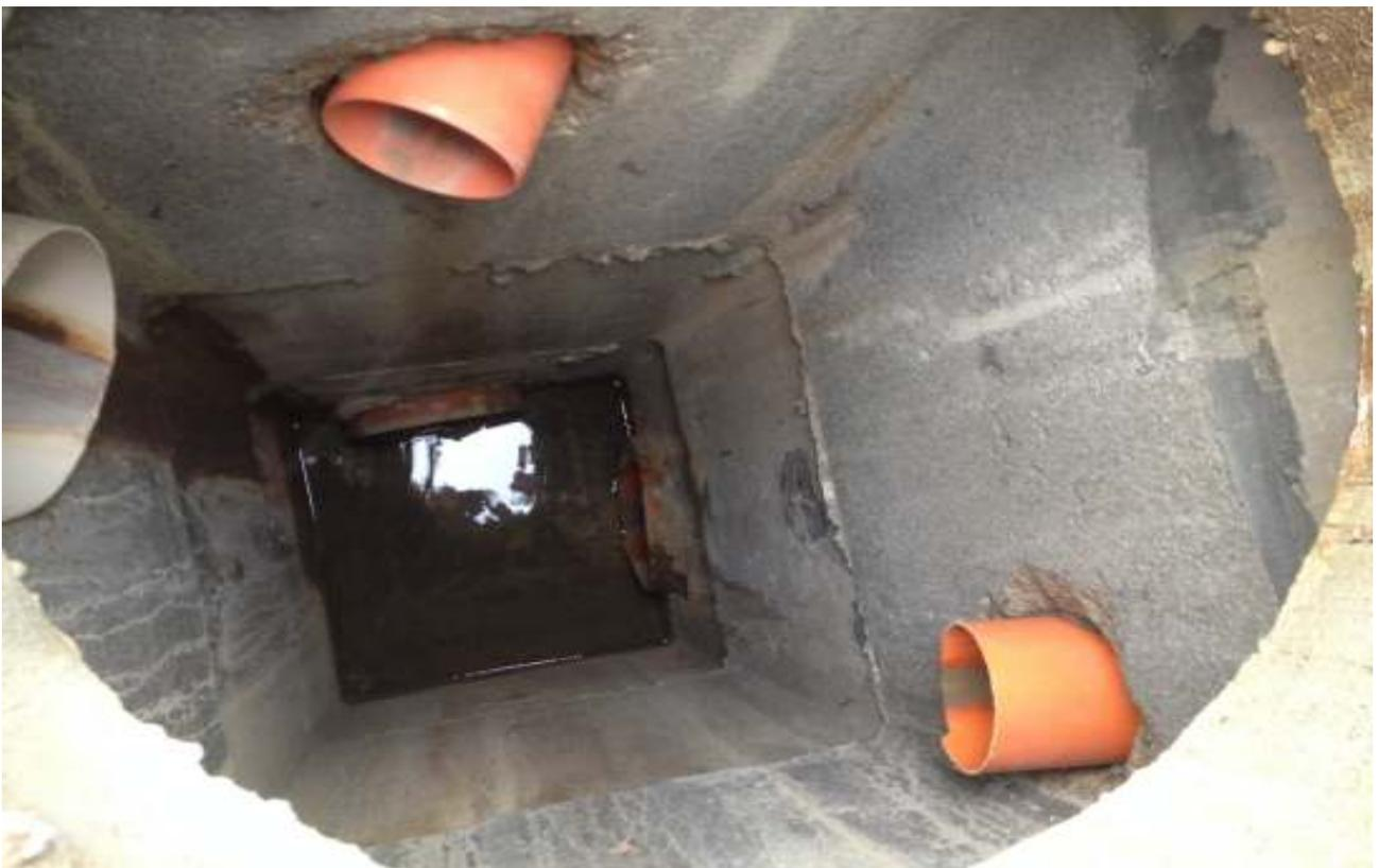
Particolare del pozzetto acque meteoriche "B" di cui alla tavola n. A del P.C. n.42 del 21/12/2012
