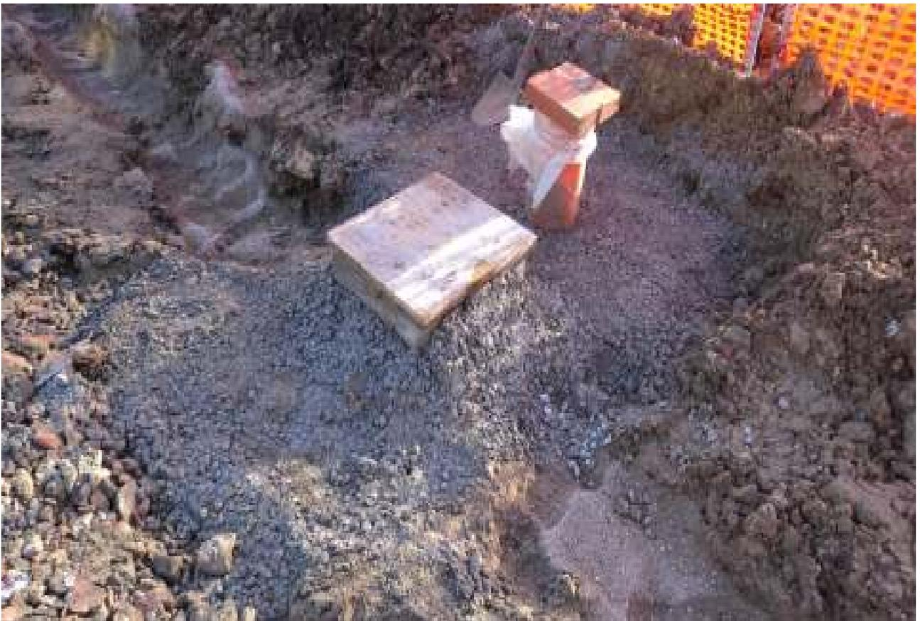
Realizzazione del pozzetto e del plinto di fondazione per i lampioni dell'illuminazione pubblica su Via Repubblica di Val d'Ossola
