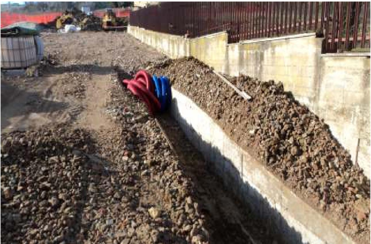
Posa dei cavidotti corrugati per la realizzazione della nuova linea Enel di BT e Telecom sul prolungamento di Via Repubblica di Val d'Ossola
