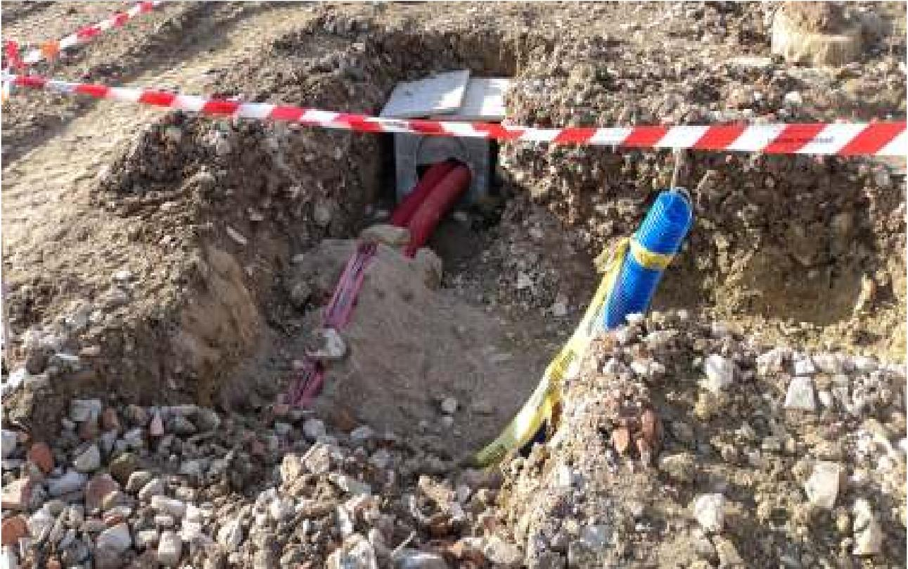
Posa dei cavidotti corrugati per la realizzazione della nuova linea Enel di BT e Telecom sul prolungamento di Via Repubblica di Val d'Ossola
